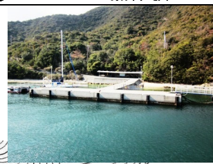
①いえしま自然体験センター桟橋
